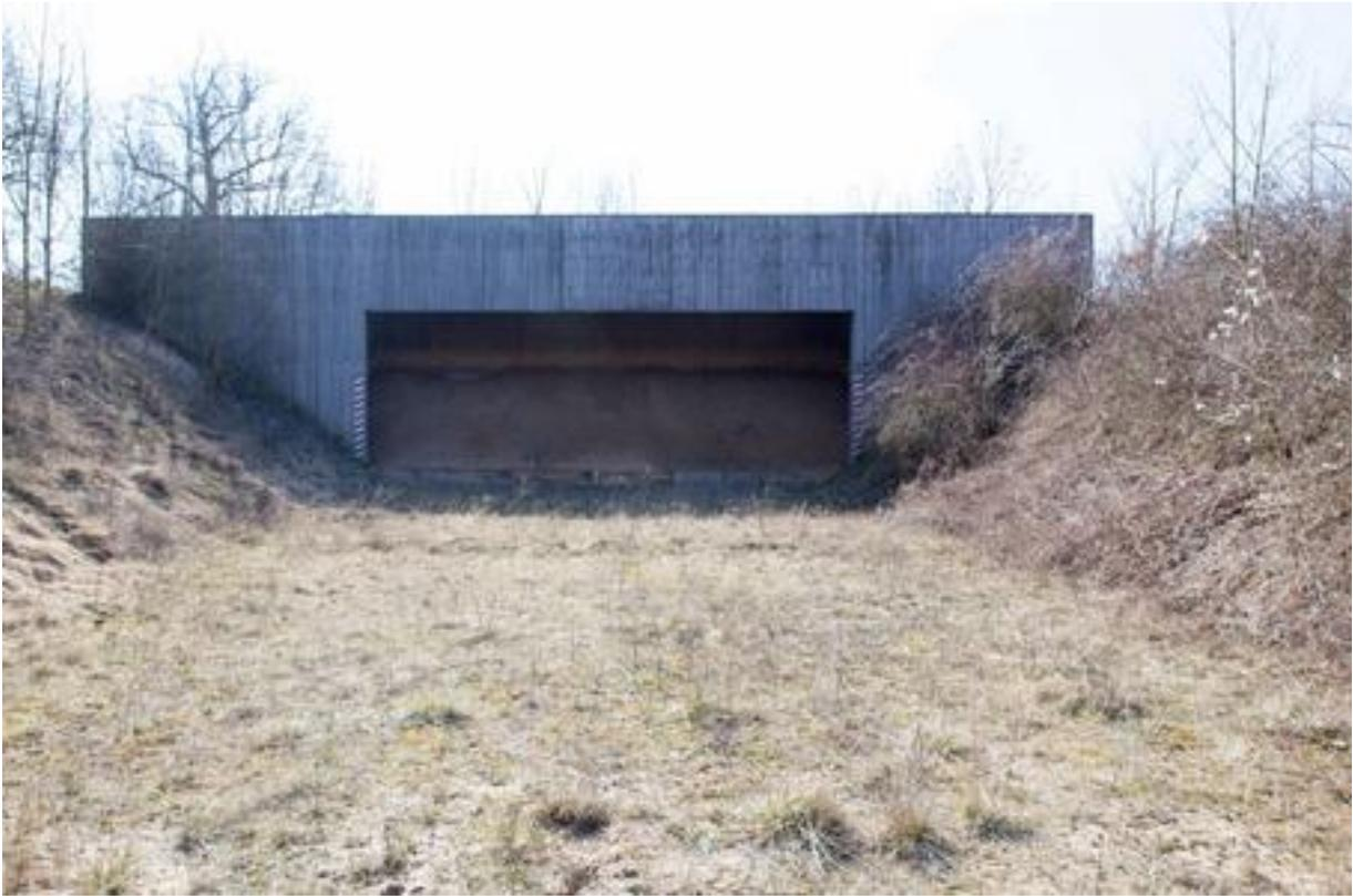
**Abbildung 11: Kugelfang des Pistolenschießplatzes im Norden des Plangebietes.**
