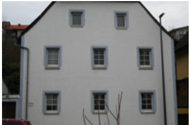
Lochfassade mit gleichmäßiger Fensteranordnung
