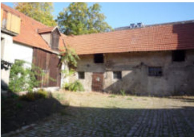
Vierseithof in der Hauptstraße mit offenporigem Natursteinpflaster
