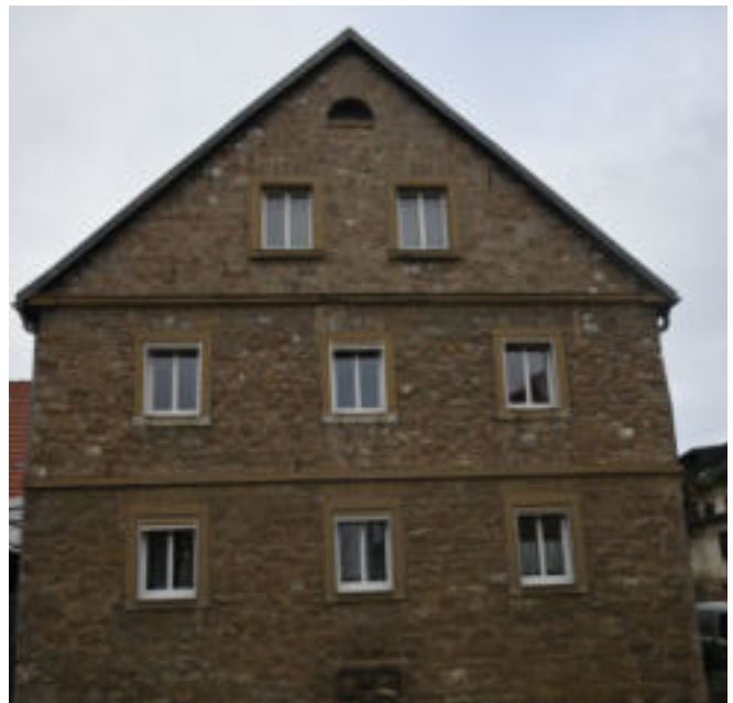
Lochfassade mit gleichmäßiger Fensteranordnung
