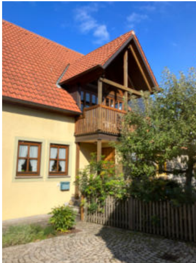
Zwerchhaus mit integriertem Holzbalkon über Hauseingang
