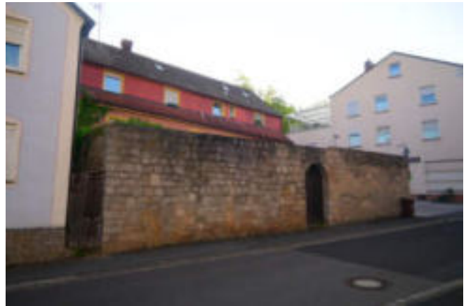
Abschluss zur Straße mit Natursteinmauer und Fußgängerpforte
