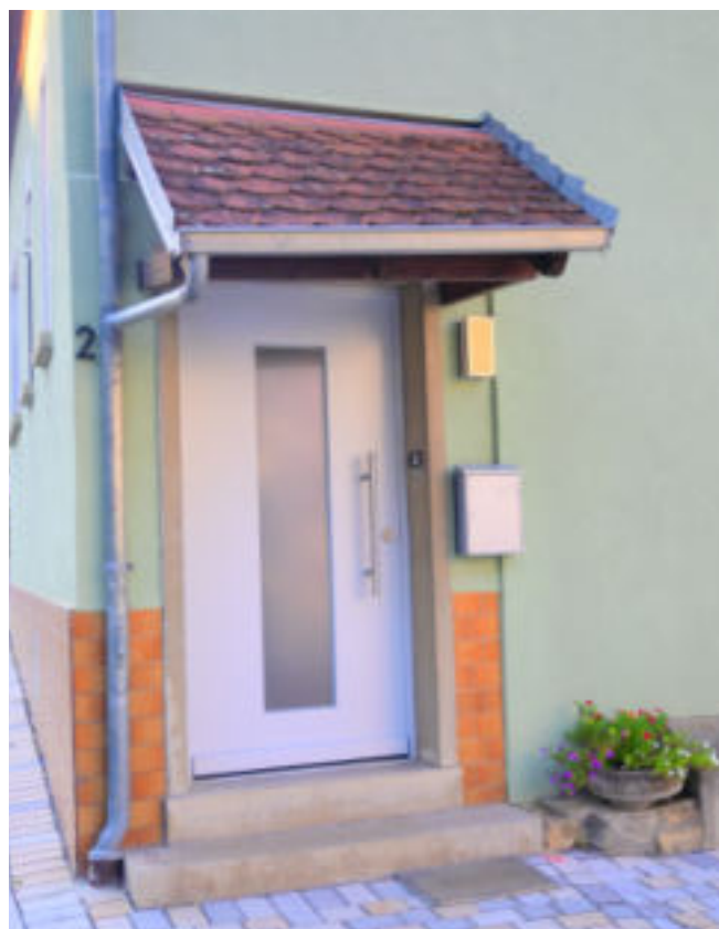
Moderne Haustüre und Vordach mit Ziegeldeckung (Schulweg 2)
