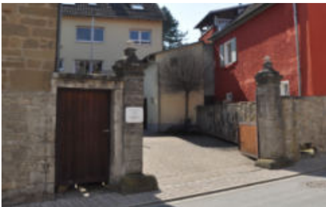
Historische Torpfosten mit seitlicher Fußgängerpforte, Hoftor fehlt
