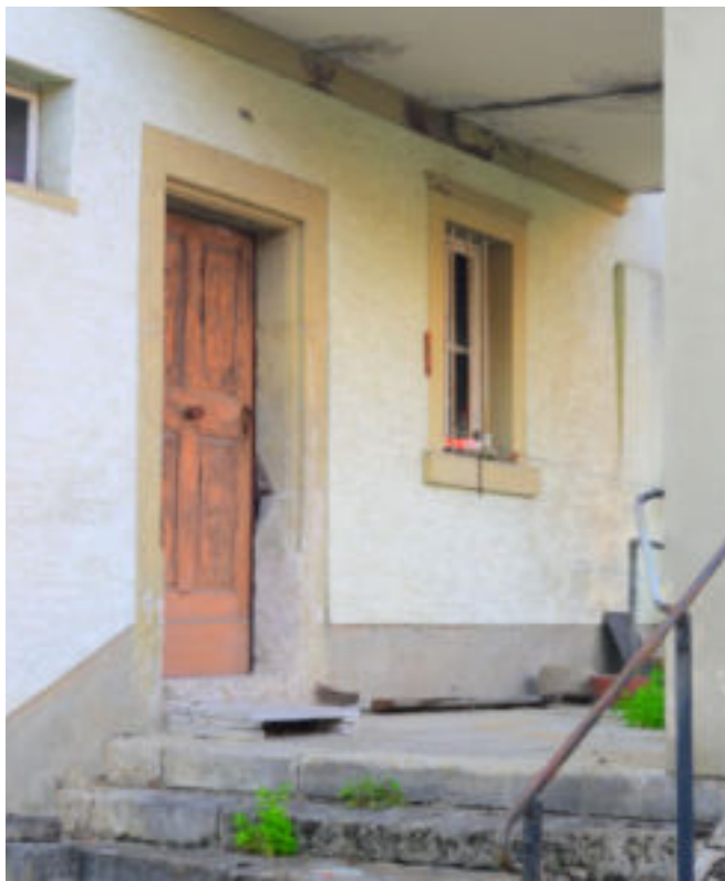
Hauseingang als Vier-Felder- Gründerzeittür im privaten Innenhof (Hauptstraße 35)
