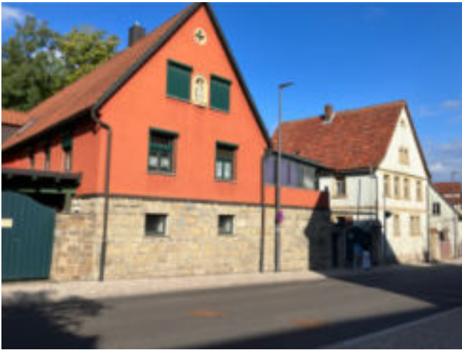
Satteldach als übliche Dachform
