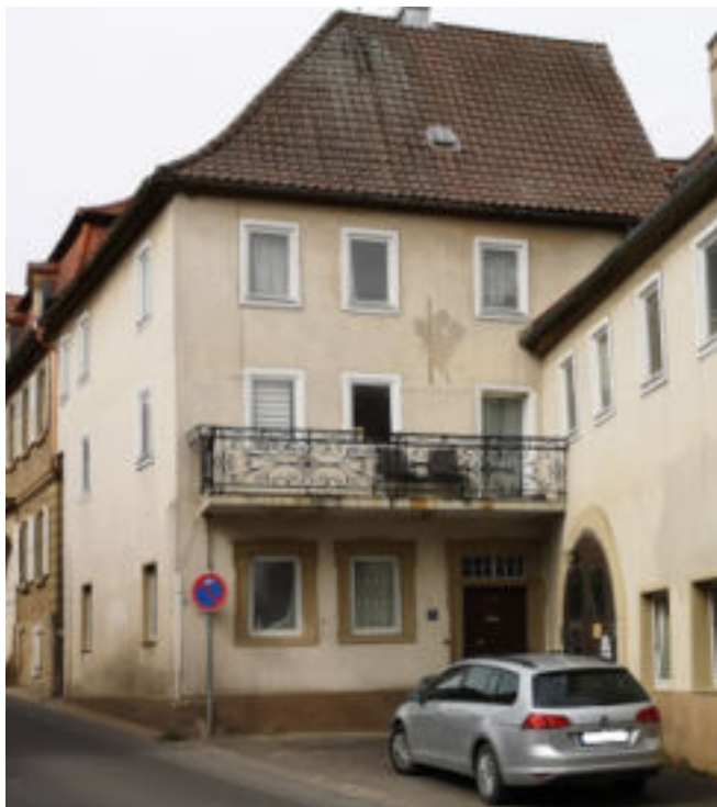
Balkon als leichte Metallkonstruktion (Bsp. Mainstockheim)
