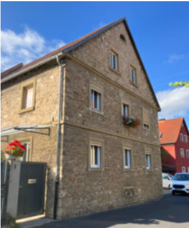
Wohngebäude aus Naturstein-Sichtmauerwerk mit Gurtgesimsen und Fenstergewänden aus Naturstein
