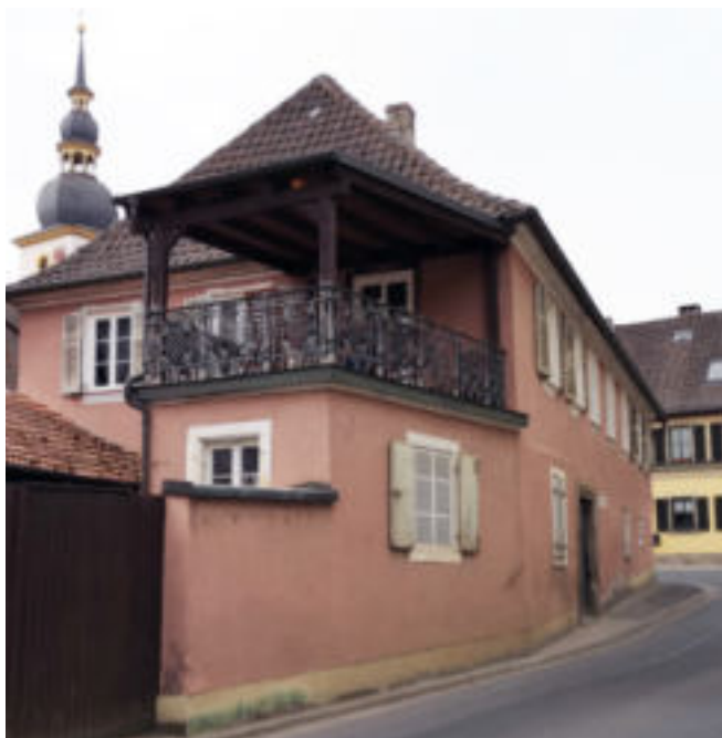
Anbau mit überdachtem Freisitz (Beispiel Mainstockheim)
