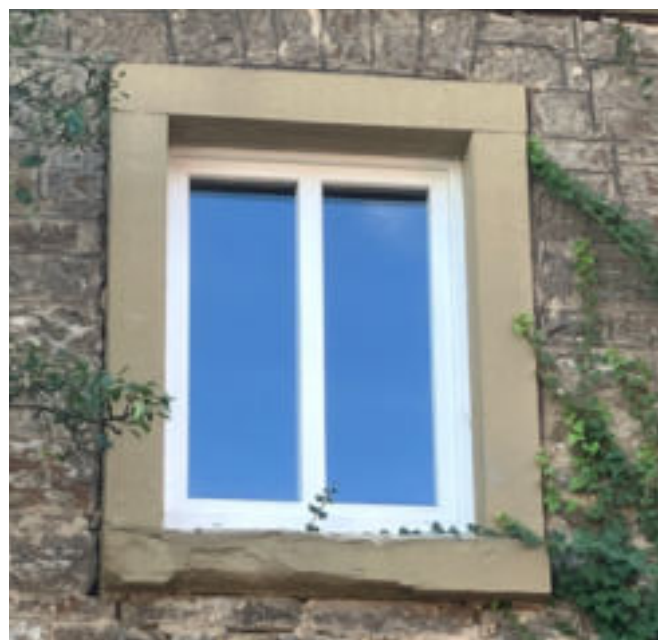
zweiflügliges Fenster in Natursteingewände
