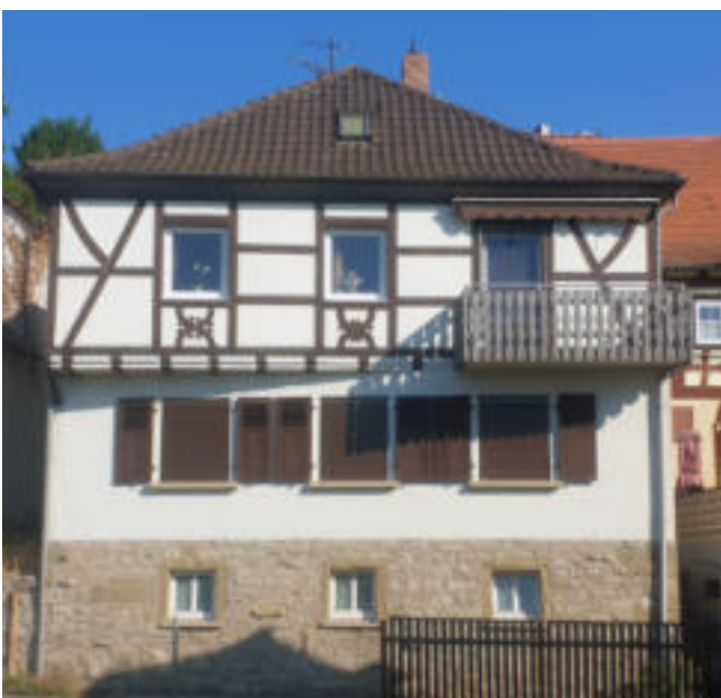
Negativbeispiel: nachträglich angebauter Balkon stört historische Fassade
