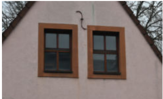
Kippflügelfenster mit Putzfasche
