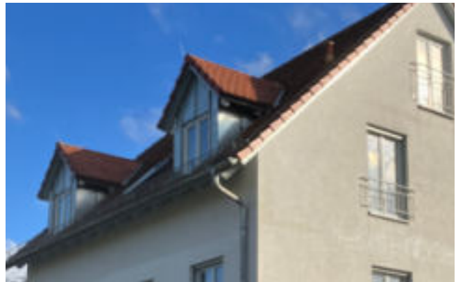
Satteldachgauben an saniertem Gebäude
