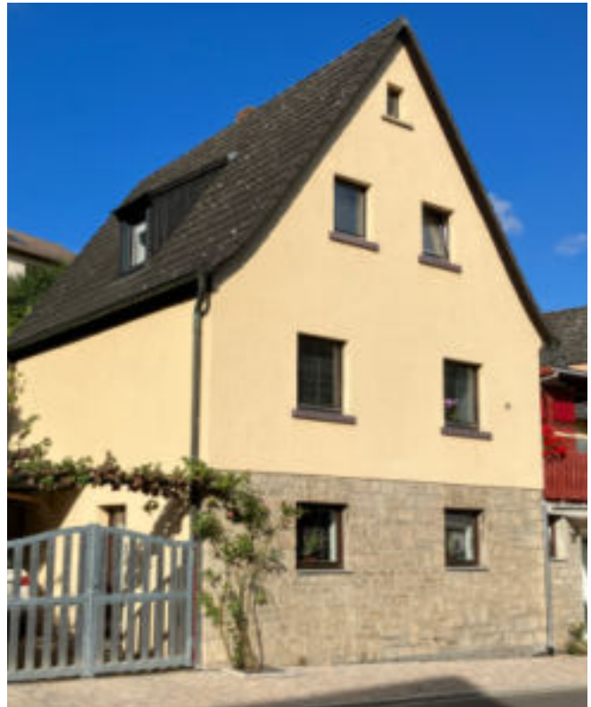
Wohnhaus mit geputzten Obergeschossen und Natursteinsockel
