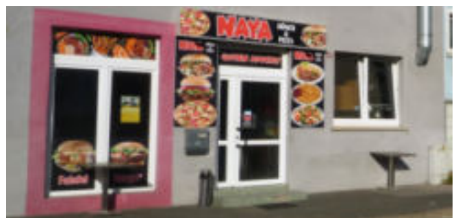
Negativbeispiel: wenig hochwertige, überladene Werbung an der Fassade und Fenstern
