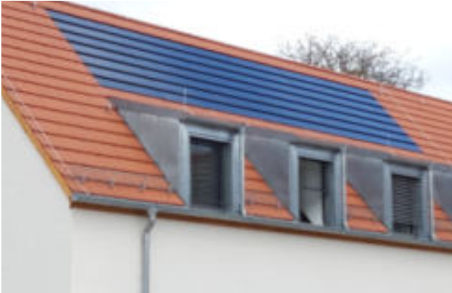
Integrierte horizontale Solarpaneele, schwarz
