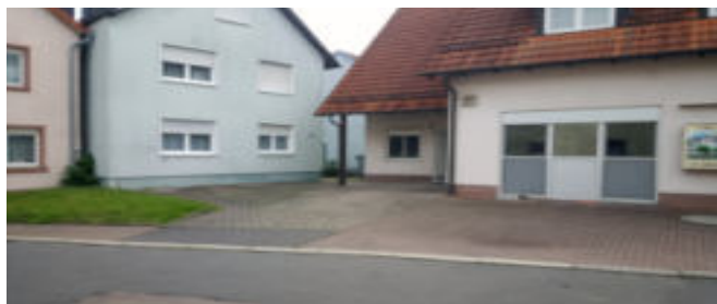
Negativbeispiel: Großflächige Versiegelung des Hofes
