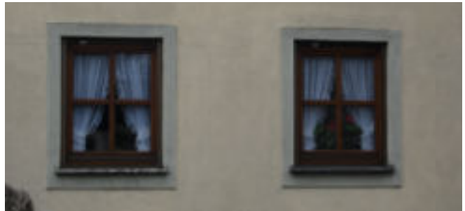
Kippflügelfenster mit Putzfasche
