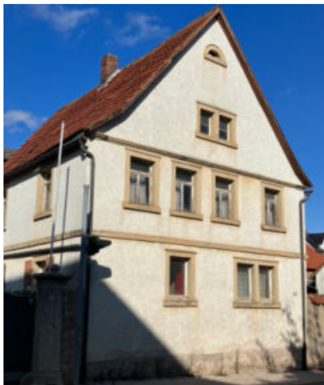
Naturstein-Gurtgesimse und Naturstein-Fenstergewände
