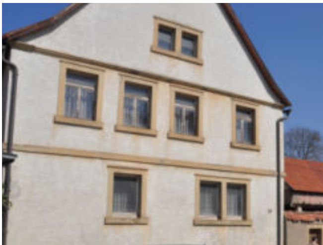
Doppelfenster an Wohngebäuden in der Hauptstraße
