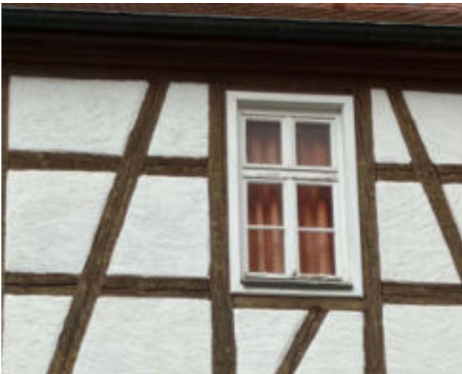
Galgenfenster mit Holzfasche
