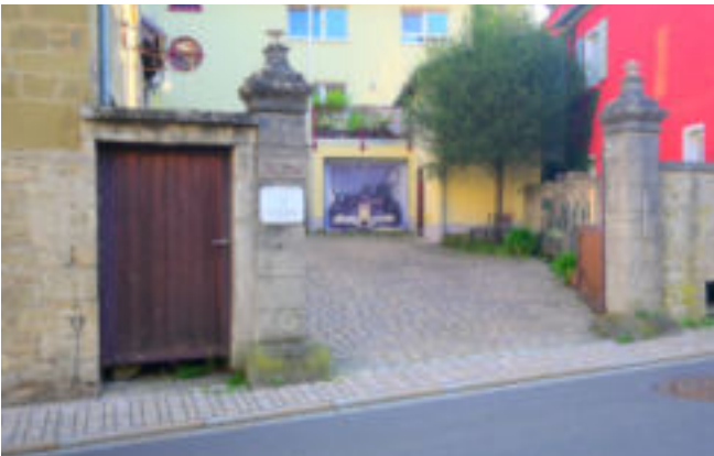
Hoffläche in der Hauptstraße mit offenporiger Betonsteinpflasterung
