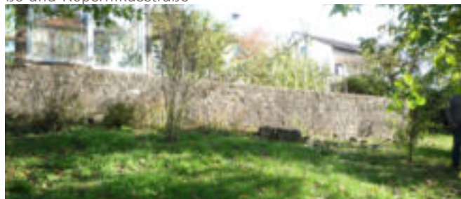
Stützmauer am nördlichen Hang
