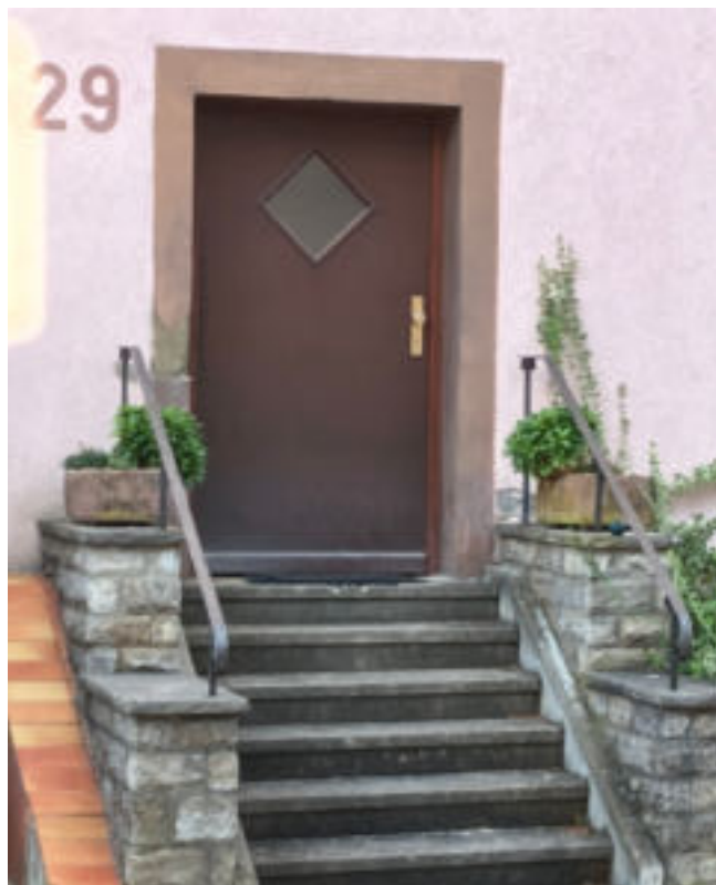
Eingangstüre mit Belichtungsfenster (Hauptstraße 29)
