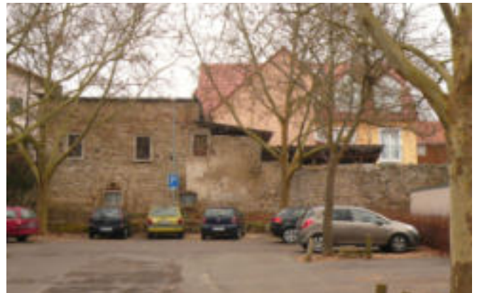
Parkplatz Alte Gasse: Zustand vor der Entsiegelung
