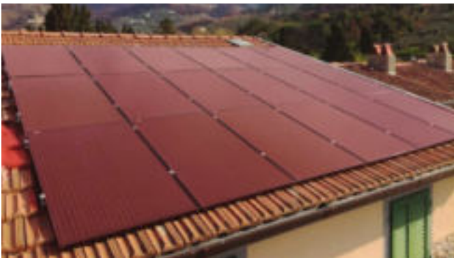
Beispiele für nicht störende Solaranlage in Farbe der Dachdeckung rahmenlos oder mit rotem Rahmenprofil
