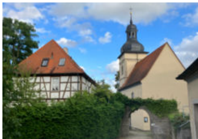
Denkmalgeschützte Gebäude in der Ortsmitte (ehemal. Pfarrhaus und Kirche St. Nikolaus)
